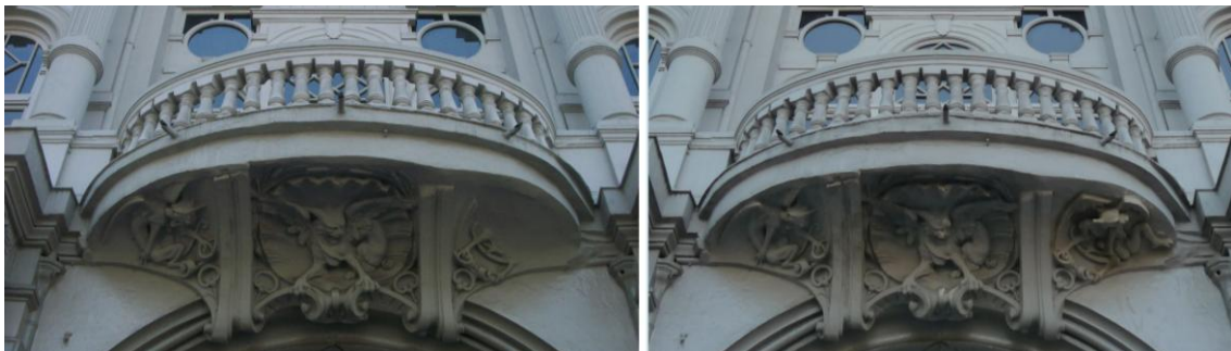
La gárgola restaurada en el Palacio Elguín data de fines del siglo 19.
